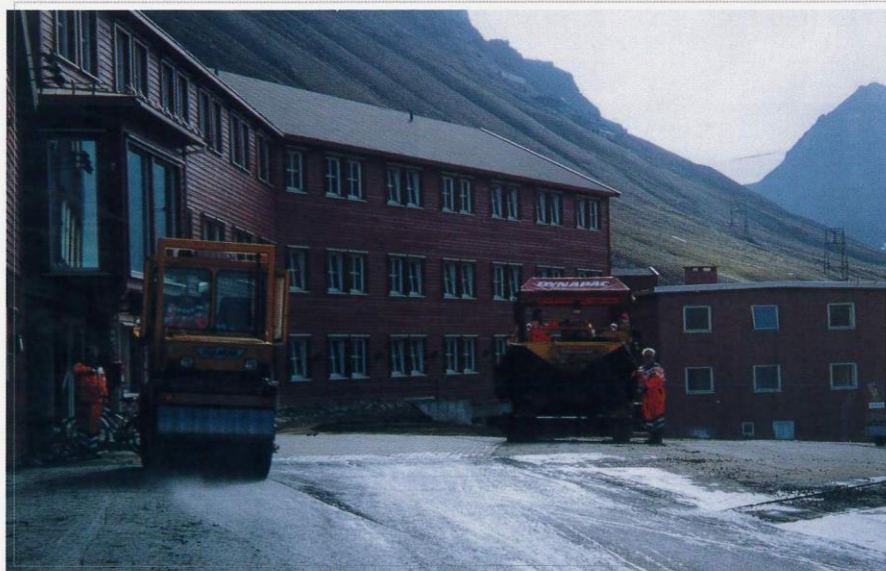
Dekkelegging utenfor hotel Funken, den gamle funksjonærmesssa på "Hauen". Nye gruve 2 sees i fjellsida bak.
