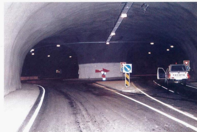
Tunnelen - klar for trafikk.
