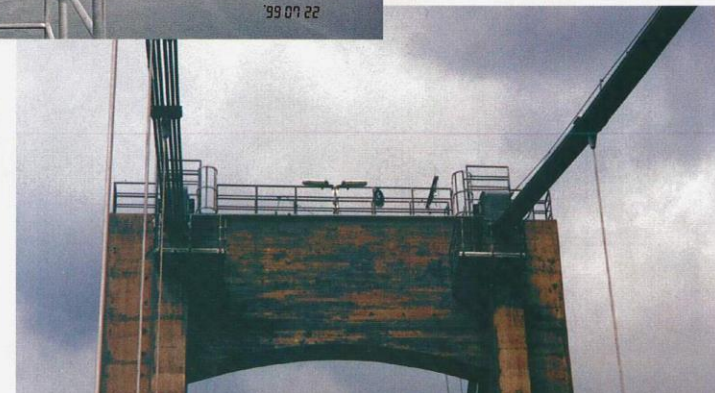
Nytt rekkverk og bedre tilkomst til kablene på tårntopp sikrer inspeksjons- og vedlikeholdsarbeidet.
