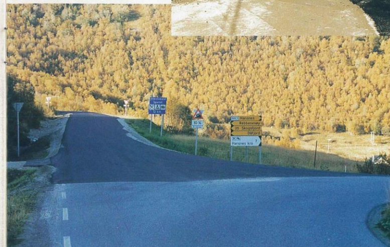
8,6 km ny veg til Dåsford.
