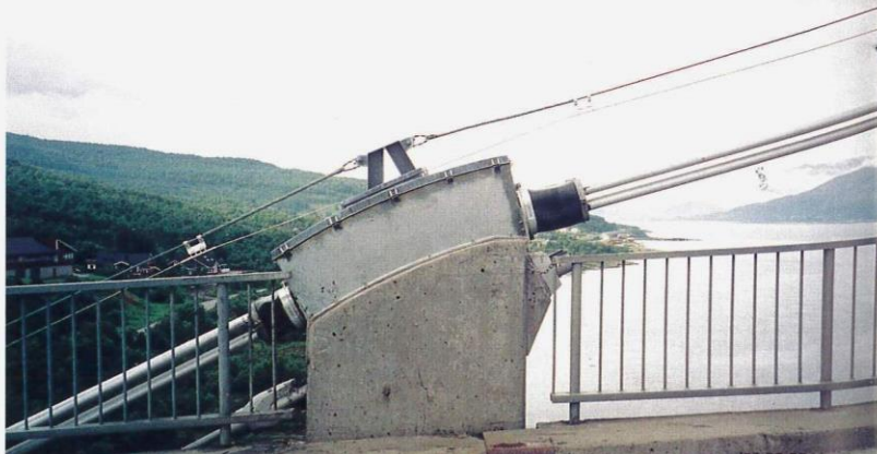
Nytt rekkverk og bedre tilkomst til kablene på tårntopp sikrer inspeksjons- og vedlikeholdsarbeidet.
