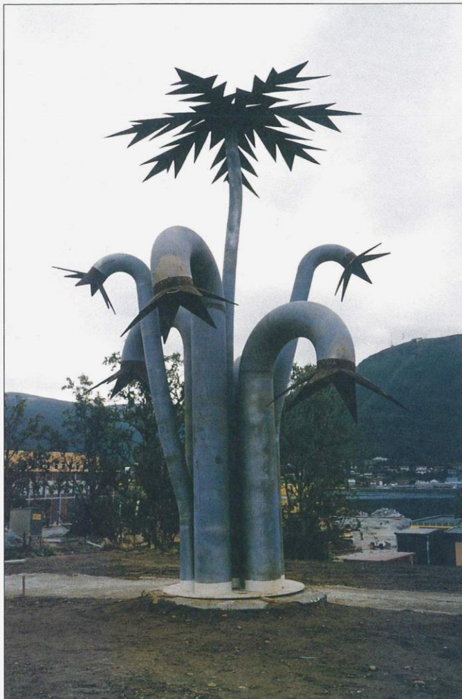
«Palmer - luft - vind» - Ventilasjonssjakt over transformatorstasjonen utformet av Harald Bodøgaard.
