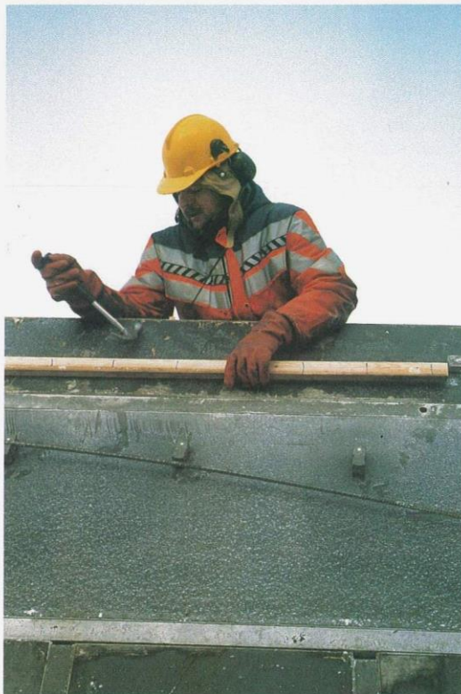
Frode Øpstad i arbeid på Telgenes undergang
