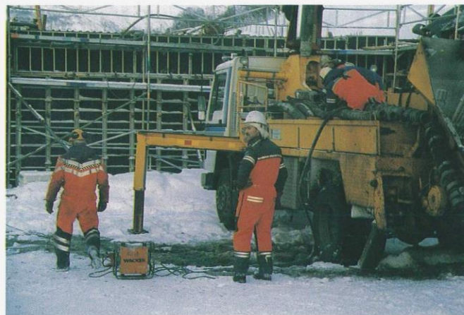
Betongleveranse til Skredhola undergang, men kulda førte til problemer med massen!
