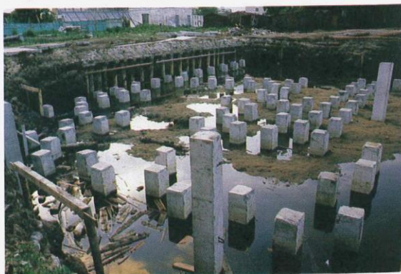
Pelefundamentering av byggeprosjekt som er stoppet pga pengemangel!
