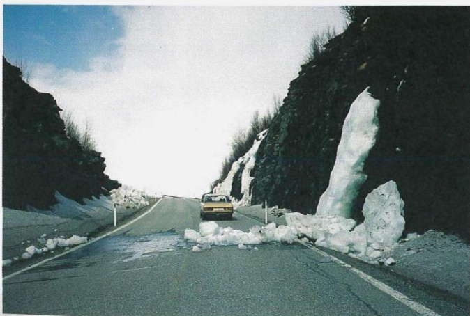
Nedfall av is på veien.
