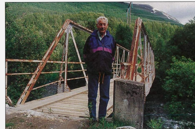
Tidligere Bomstad bru er flyttet fra sin opprinnelige plass langs E8 og til Kjempedalen litt lenger opp og godt skjult nede i skogen. Der ligger den idyllisk over Nordkjosbotnelva som et minnesmerke over en forgangen tid. Den er eneste fagverksbru av denne type og er i seg selv et lite monument over vår historie. Brua ble oppført av det svenske lappevesenet i 1888. Den anses å være et samisk kulturminne og er dermed fredet.
