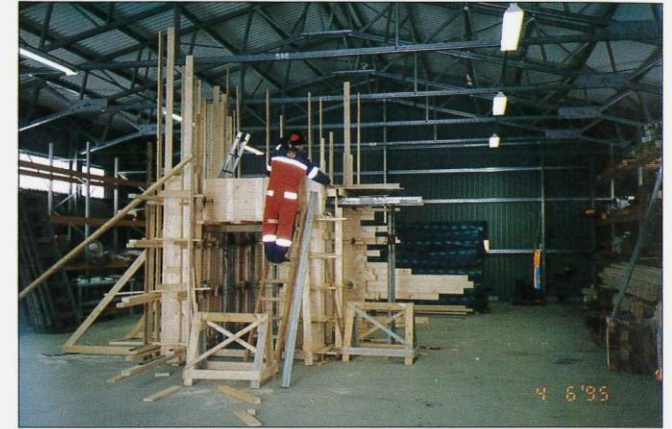
Selve fagprøven: To vegger, en bjelke og ei søyle.
