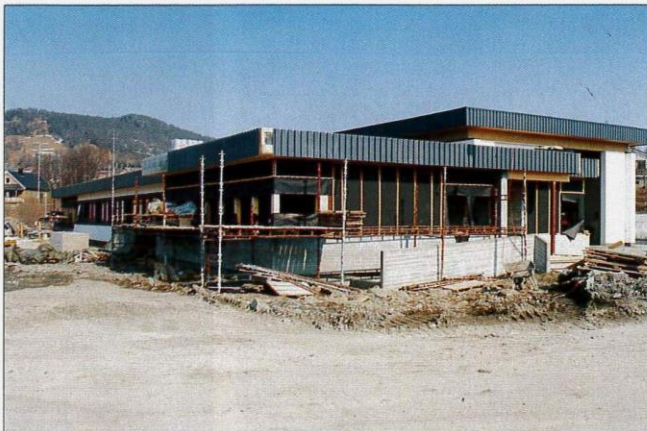
Mye rot under byggearbeidene - men utvidelsen tar form.
