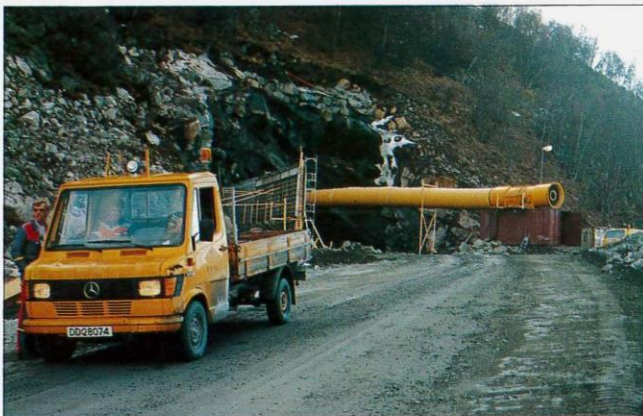
Tunnelåpningen på Dalesida.
