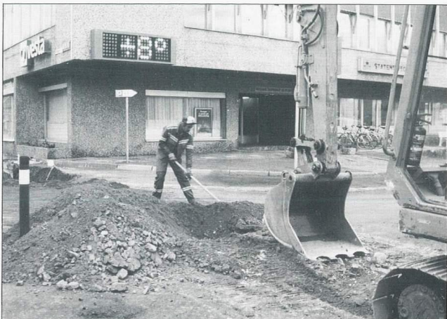
Anleggsarbeidere i Tromsø har til tider vært nært vegadministrasjonen. Her legges kabler til de variable skiltene.
