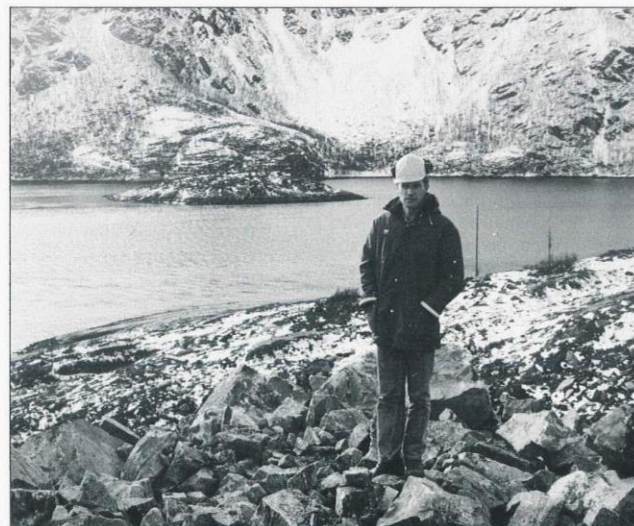
Arbeidet med Andørjas fastlandsforbindelse har pågått i ca. 2 år. Kjørbar veg fram til Mjøsundet var klar 1. mai 1992 - Toralf Bergseth ved Mjøsundet.
