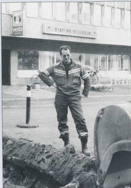
Åge Andersen i arbeid på «trappa» til vegkontoret!
