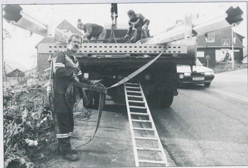
Oppsett av nye variable skilt i Hansjordnesbukta — Roald Markussen i forgrunnen
