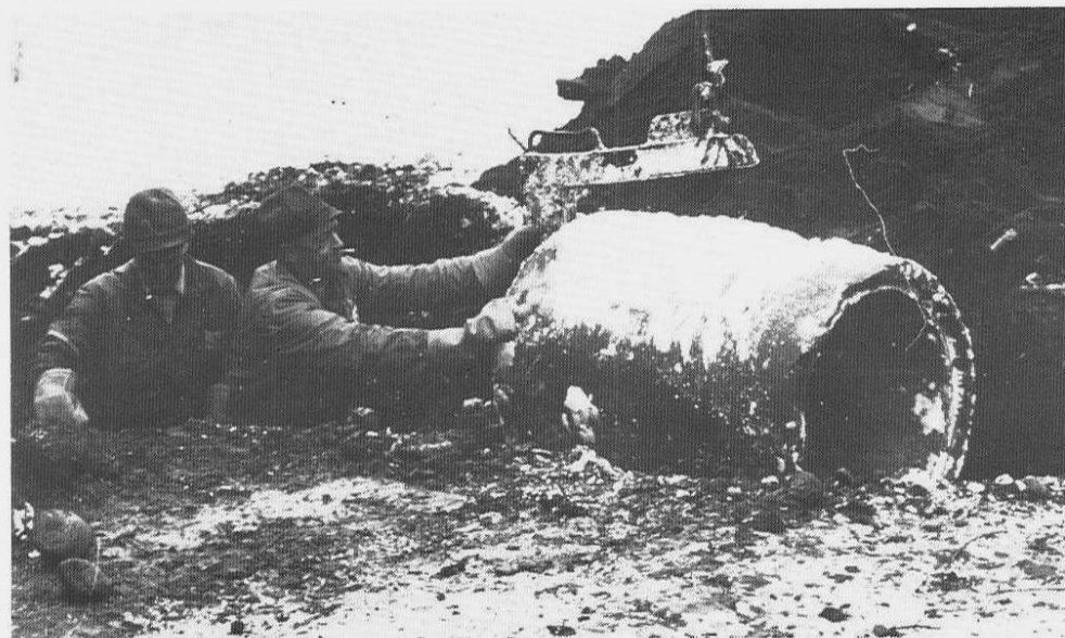
Nye stikkrenner i Fv. 265
