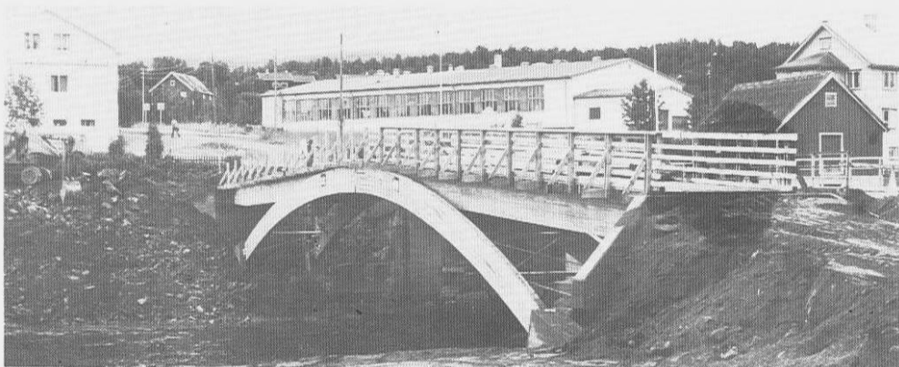
Flott bru for gående og syklende i Sørreisa. Her fotografert under bygging.
