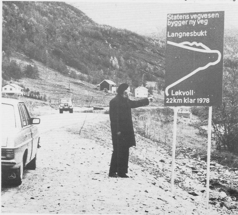
Avdelingsingeniør Karl P. Bruun kan konstatere at anlegget ble ferdig før tiden
