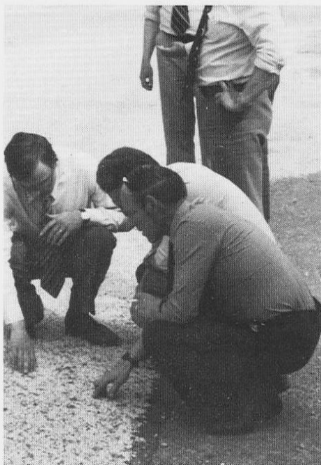
Vegsjeff Herleiv Solberg studerer lys asfalt med stein fra Norge og bitumen fra Sovjet.
