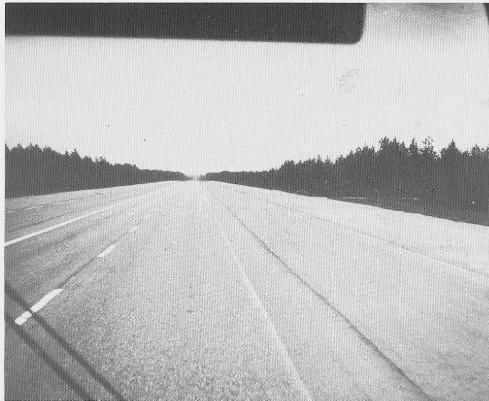
Finsk veg med utvidet bankettbredde til bruk som nødflyplass
