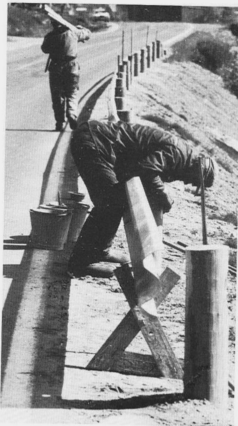
Rekkverksoppsett hører til sluttarbeidene på et anlegg, fra rv 850.
