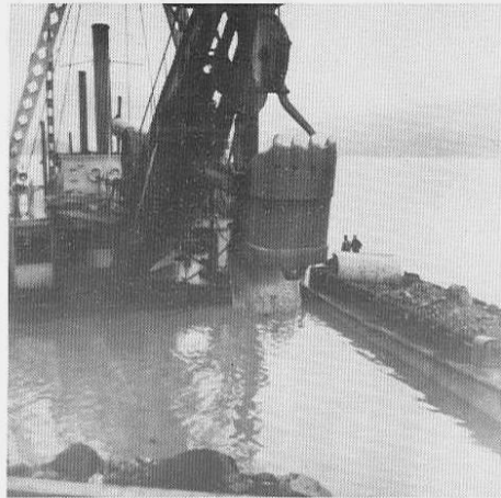
Fra mudring for ferjeleie i 1940 – Ekskavato 6 i arbeid
