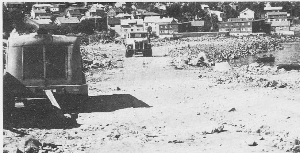
Fyllingen i Harstadbotn — parsell del mellom 1. og 2. byggetrinn ligger i høyre billedkant.
