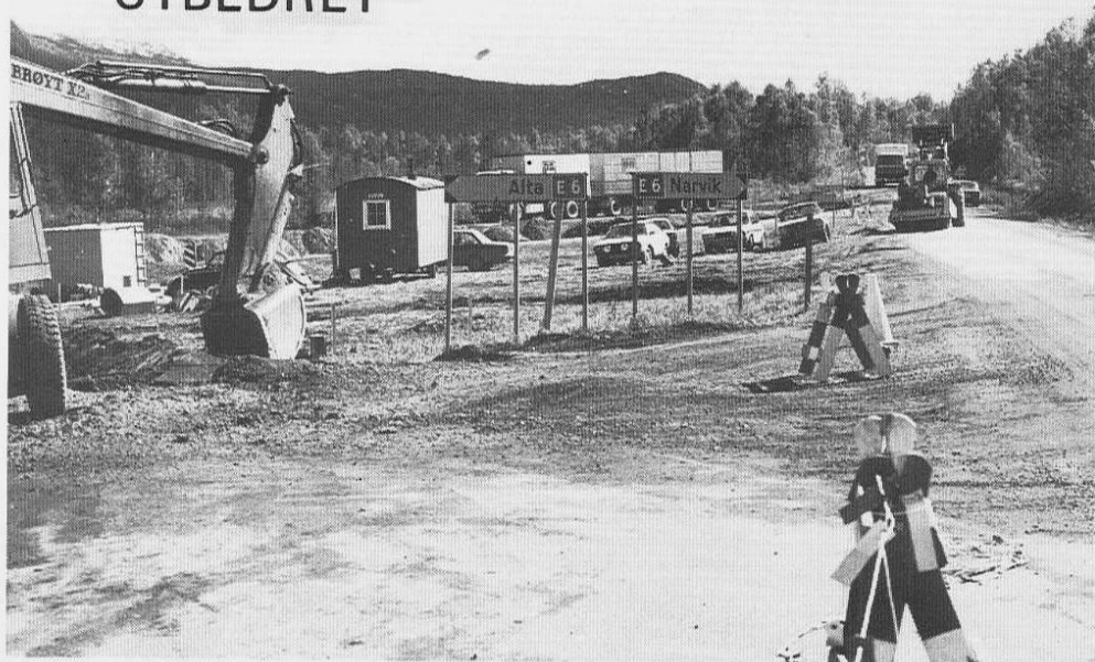
Fra arbeidet med Buktamo vegkryss
