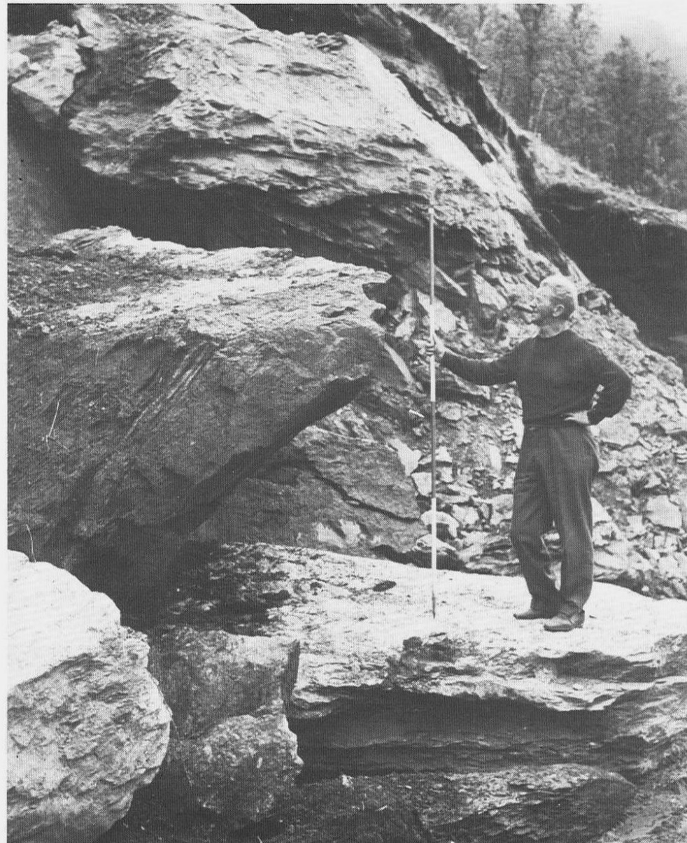
Oppsynsmann Karl Skogstad ser noe betenkt på de store steinblokkene som har rast ut på anlegget Langmyra — Bukkemyra. Han forsikrer imidlertid om at det ikke skal bli slik rasfare når nyvegen tas i bruk. Imidlertid ser han ikke bort fra at vejen kan ha tatt bort fundamentet for en del skråninger i terrenget der innslaget av leire er stort. For vejen og trafikken er det ingen fare, men vi kan nok få stygge sår i terrenget der overflaten raser ut.
