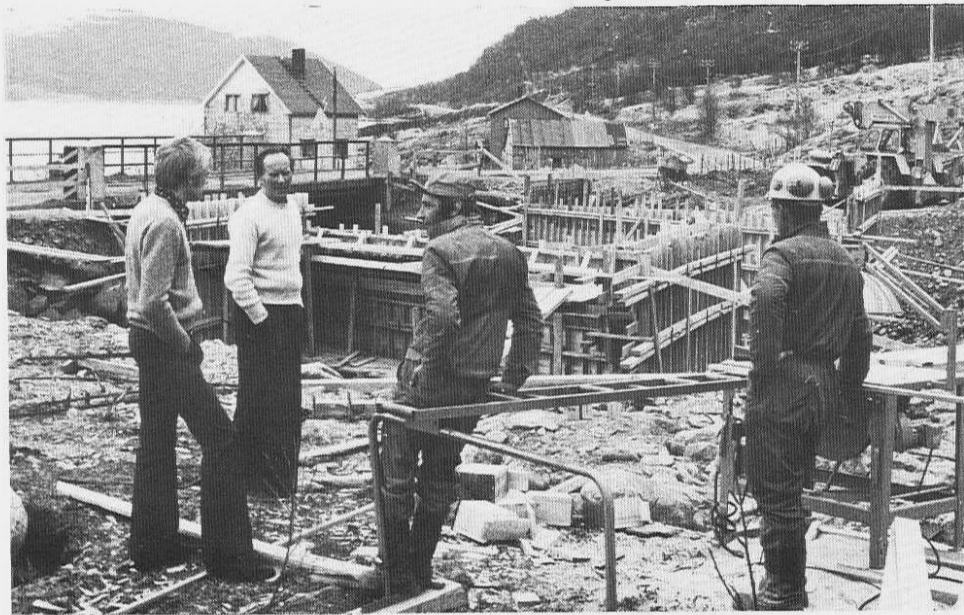
Her i gang med ombygging av Berg bru.
