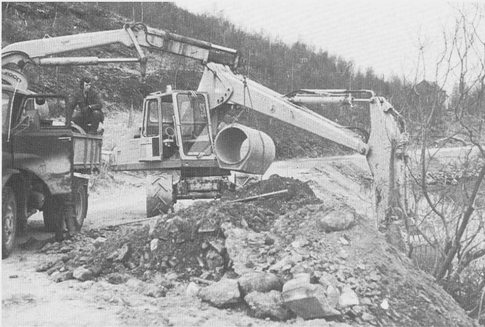
Nye stikkrenner legges.
