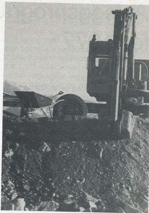
Rekkverksarbeid fortsetter nok.
