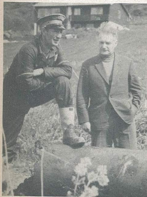
Vegmesteren i prat med Ivar Iversen om utskifting av stikkrenner i Kastfjord.
