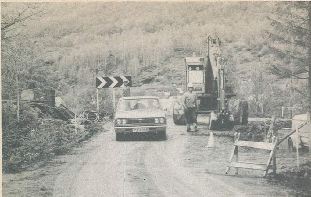
Det kan være trangt for trafikantene der arbeid pågår.
