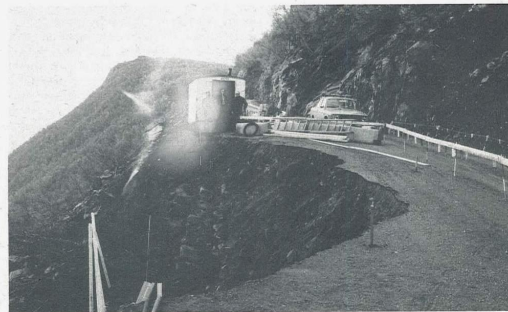
Utrasing på fv.anl. Grunnvassbotn — Aun som likevel ble ferdig som planlagt
