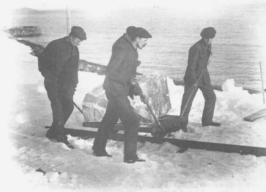
BALANSETRALLEN - ENSPORET TRALLEBANE SAXEGAARDS OPPFINNELSE. HER SYNES VI Å KJENNE IGJEN ARNT MARKUSSEN NÆRMEST OG OLAF RUSTAD T.V.
