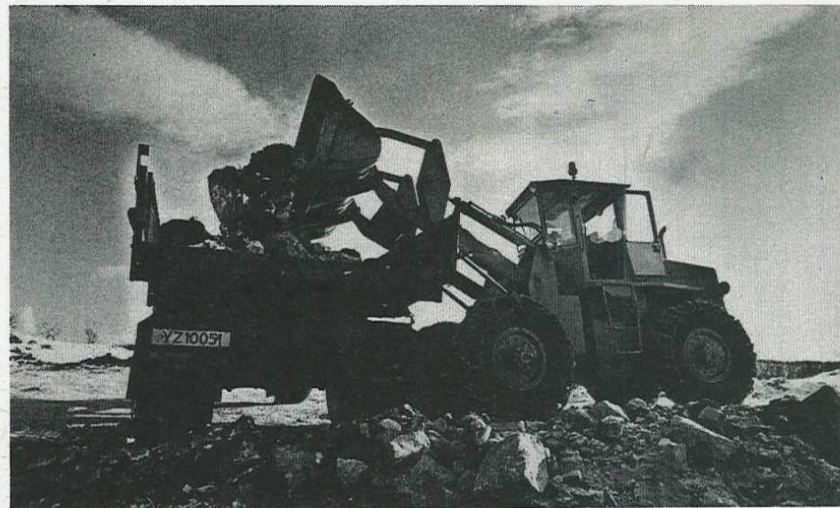
ØVERST OG NEDERST FRA ARBEIDET I "SLYNGEN" OG TIL HØYRE ANLEGGSBESTYREREN, GUSTAV DAREN OG FUNG. ANLEGGSSJEF THOR JAKOBSEN MED ELGSNES I BAKGRUNNEN
