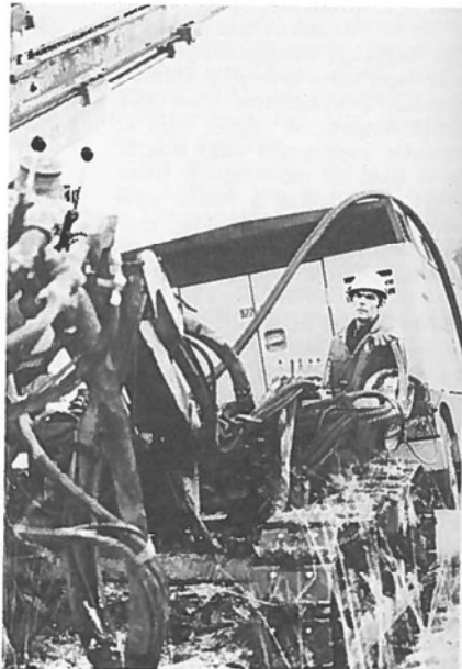
Ny parsell på rv 83, Blomjoten — Kilahamn skal påbegynnes — her Terje Johansen i forberedelsene med grunnboringsutstyr.
