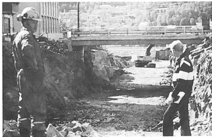
Over denne skjæringen og på begge sider av brua er det "lokket" skal legges.
