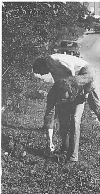
Stadig nye ledninger "dukker opp" — høyspenstkabel er påvist og Trond Fosshaug "spray-merker."
