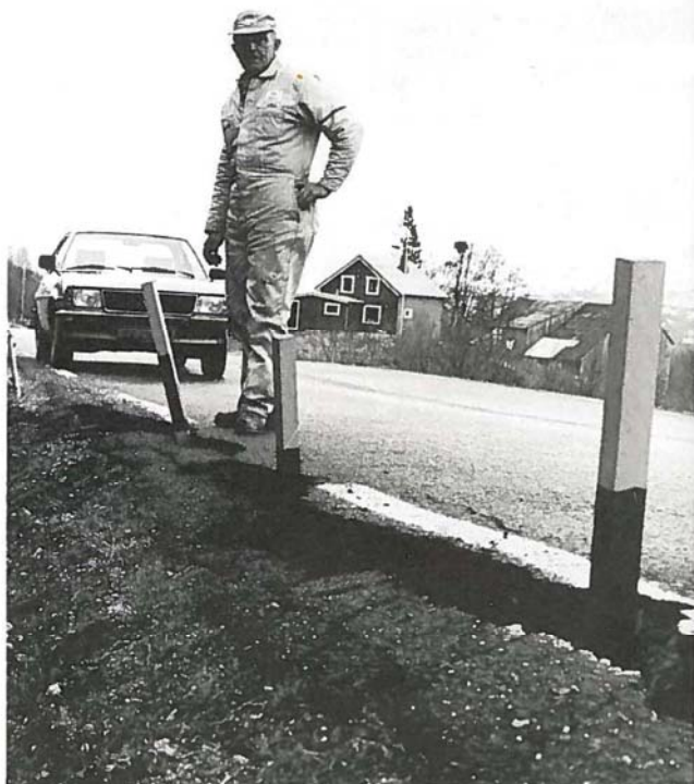
Ingebrigt Dahlberg og teleskader på rv. 84.
