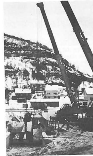
Montering av brubjelker på Bergselv gang- og sykkelbru. Foto: Jan Jørgensen.
