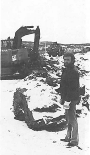
Trond Fosshaug kan se fram til å få gjort ferdig anlegget Høgda - Grunnvassbotn.
