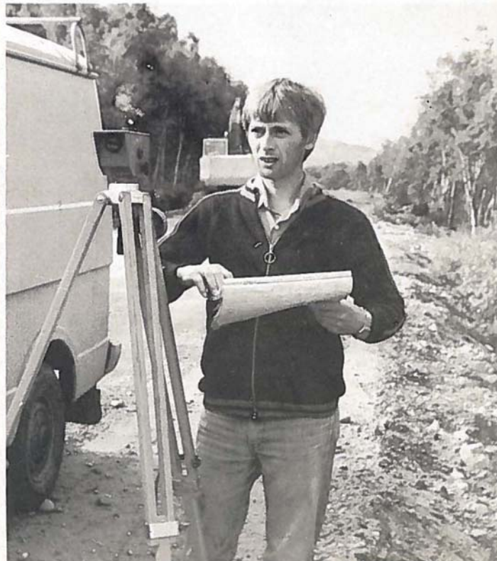
Tormod Nergård i arbeide på rv 84
