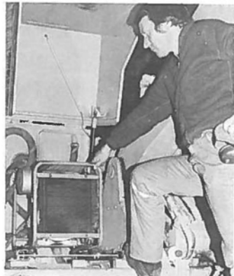
Rolf Hagensen viser kompressoren som er påmontert gravemaskinen for å bringe smøring til hammeren.
