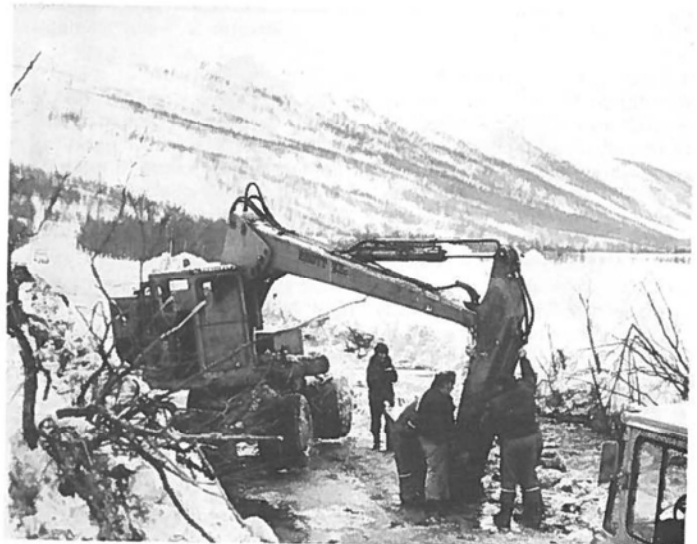
Situasjonsbilde fra ryddearbeidet.
