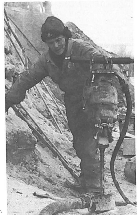
Håndholdte bormaskiner volder fortsatt bekymringer. Her Ivar Bakklund.
