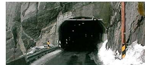
Gammel tunnel (Korsnestunnelen på rv 78)
