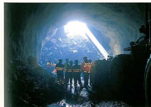
Raftsundtunnelen sett innenfra.
