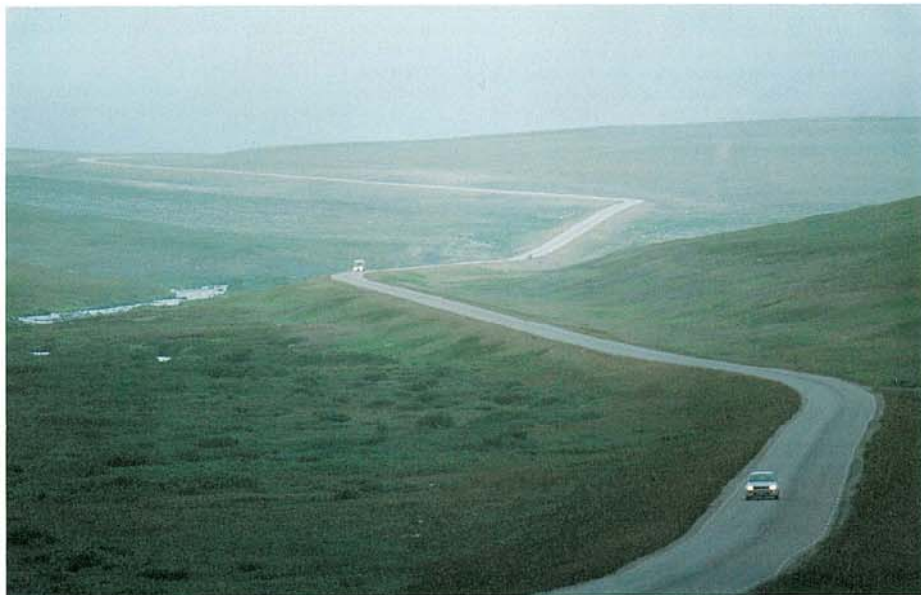
Den siste anleggsparsellen på helårsvegen til fiskeværene Berlevåg og Båtsfjord ble ferdig 1989. Riksveggen
