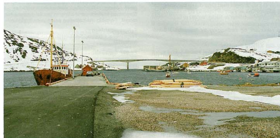
Havøysundbrua er 293 m lang og regnes som verdens nordligste større bru. Brua ble offisielt åpnet 5. desember 1986. Sammen med Havøysundvegen, som ble offisielt åpnet 18. august 1988, fikk befolkningen
