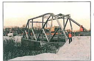
Måskejøhka bru ble fullstendig ødelagt etter en påkjørsel. På bildet prøvkes bruas med Biltittelysnet bil for å teste bæreevnen. Foto: Hestne Drage
