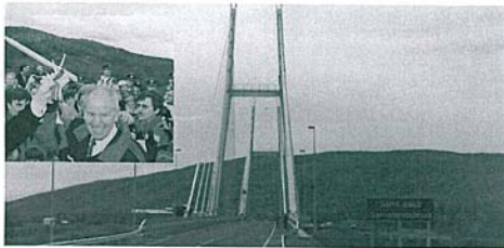
Åpning av Samelandsbrua 30. september 1993 ble en folkefest for alle i Tanadalen. Den offisielle åpninga ble foretatt av Finlands trafikkminister Olla Norrback og samferdselsminister Kjell Opseth fra Norge. (Foto: Steinar Sværen)
