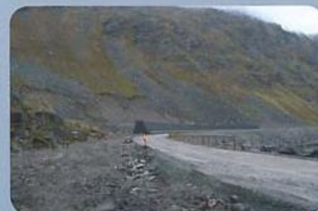
Rassikring Eiterfjorden ved Havøysund
