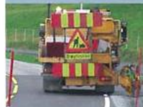
Oppsett av brøytestikker på E10
