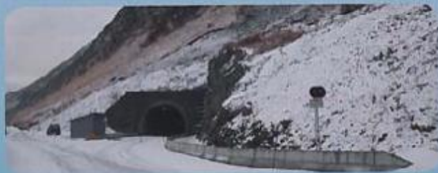
Liantunnelen fra Dalsetra
