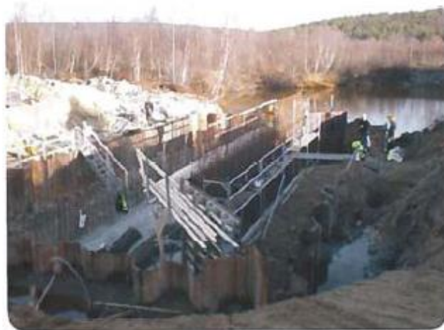
Utbedringsarbeid i Tandalen høsten 2010
