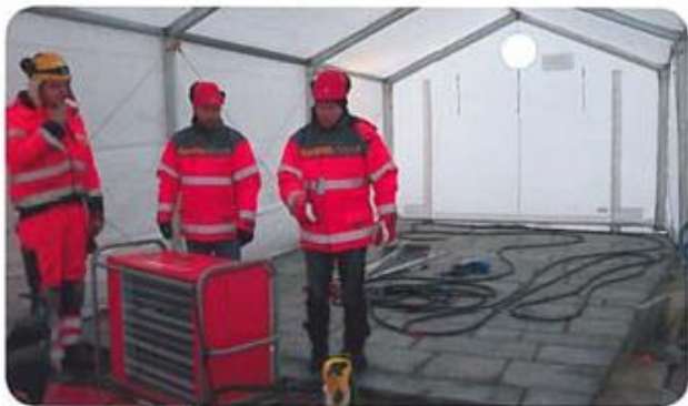
Byggeleder Torgeir Dahle og kontrollingenør Uddbjørn Uppgård i samtale med entreprenøren som legger flisene.
