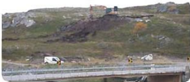
Endelig er arbeidet i gang
