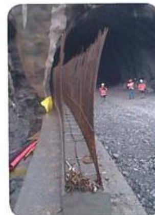
Silje, Maria får instruksjoner i tunnelbolting av Tor Sverre Andersen
