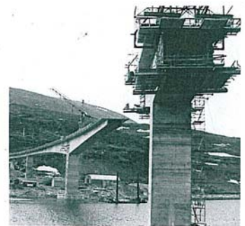
Havøysund bru under bygging. Sammenkoblingen skjedde torsdag 21. august 1986 kl. 1530...
