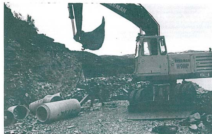
Fra Havøysundvegen og arbeidet på Snaffordsida.
