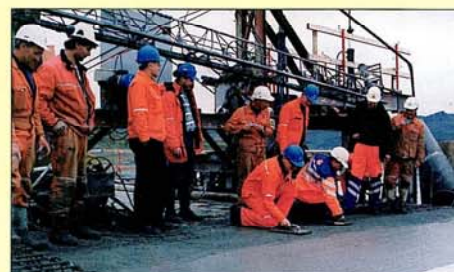
Svein Roska (t.h.) og Sigvald Stene pussar om kapp de siste metrene på støpen av brua.
