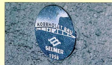
En plass på brua ligger et lite minne etter entreprenøren.
