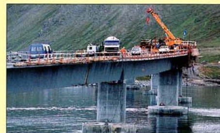
Siste støpedag for brudekket 4. september 1998.
