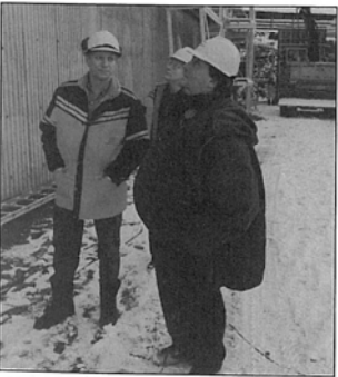
Anleggsleder Torbjørn Johannesen (t.h.) viser sammen med oppsynsmennene Frank Opgård og Per Inge Pedersen (bak) fram kulverten i Finnmarks første toplan-kryss.
