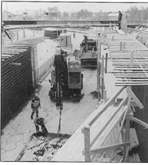
Det har vært en kald vinter i gropa for anleggsgjengen i Alta. 27 kuldegrader er ikke for hvem søm helst, men arbeidet går framover etter skjema.
