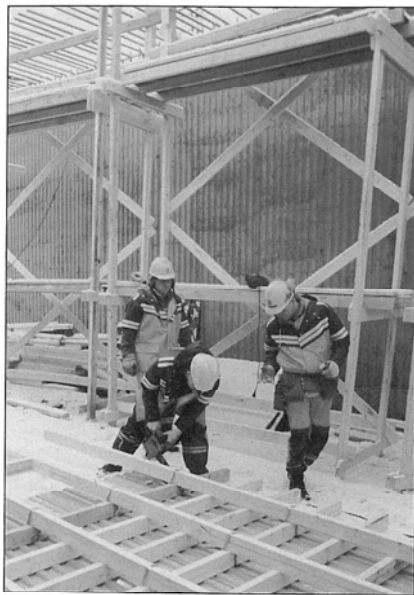
På anlegget er de selvhjulpne med det meste. Her legges siste hånd på verket på en del av forskalingene til kulverten.
