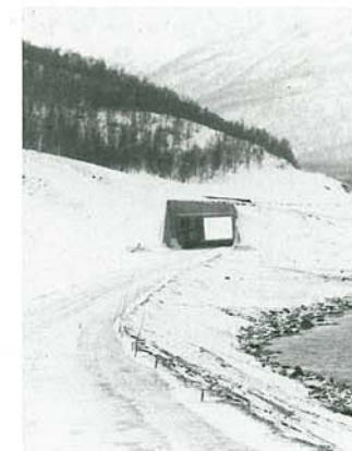
Rasoverbygg ved Stålnes.
