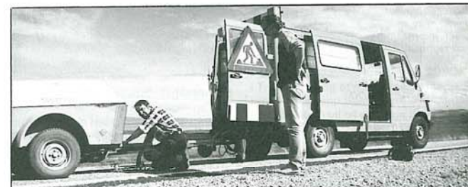
Det er viktig med nøye kontroll av utstyret før målingene tar til. Aronsen har gjennomført 50.000 målinger. Geolog Lars Haukvik bivåner utstyrssjekken på målebilen.
