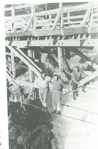
Den første bro over Adamsfoss etter krigen ble oppført på rekordtid. Ingeniør Holt — i midten — og Johannes Foslund sittende til høyre.
