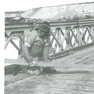
Så snart nybrua ble åpnet startet arbeidet med å rive den midlertidige brua. Her er det Nils Turi fra vedlikeholdet som har begynt å fjerne brudekket.
