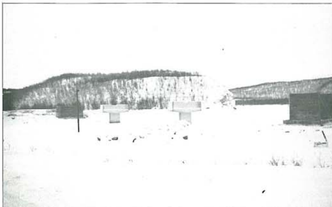
Slik så brua ut i begynnelsen av desember. Det er lett å se at det er et stort byggverk som er under arbeid. Det blir også en sikker bru, og ingen isdemning skal klare å ta knekken på denne.
