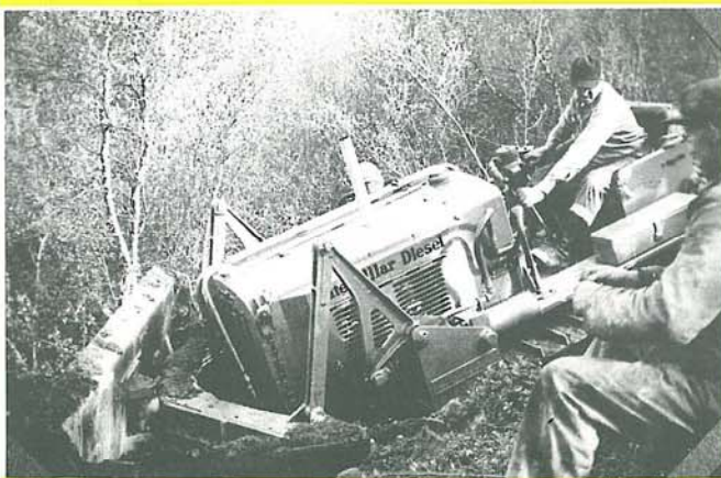
Arbeide i bratt terreng. Demonstrasjon av ingeniør Harold Shawls.
