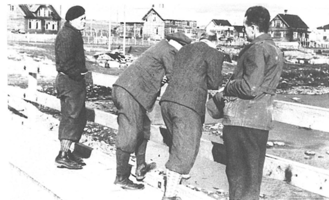
Fra Godtfred Karlsens arkiv har vi fått dette bildet for å illustrere artikkelen fra Børresen. Dette er på Skallelv bru i 1946. De høye herrer som tar bruarbeidet nærmere i øyensyn er: overingeniør O.A.B. Torpp, avd.ing. A.J. Torvik, vegsjef K.H. Oppegaard og avd.ing. F. Solen.
