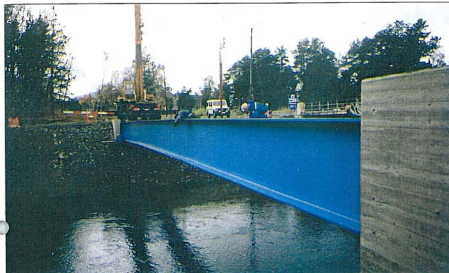
Det viser igjen med en klar blå farge på brubjelkene på Tørrfossen bru i Alta. (Foto: Anleggsavdelingen)
