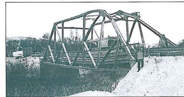
For å finne ut hvor mye brua tålte ble biler med forskjellig tyngde kjørt over. Biltilsynets kontrollbil med Roger Karisari bak rattet fikk en spennende tur over brua for vektgrensen ble satt til fire tonn totalvekt. På bildet ser vi også hvordan brua ble deformert av de enorme kreftene da den ble påkjørt.
