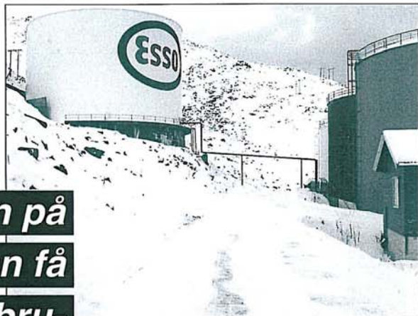
Vegen fra Storbukt til tunnelen går mellom tankene i anlegget til oljeselskapet Esso. Det skal sprenges like i nærheten, og det arbeides derfor med sprengningsplaner og ladeplaner slik at ikke tankene skal skades.
