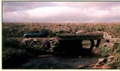
Sennalandet. Eksempel på 2 generasjoner vege med bru/stikkrenne. Gammevegen med betong-bru er bygget 1934 - 1940, nyvegen med stikkrenne av aluminium er fra 1968 - 1972. Legg merke til hvor mye høyere i terrenget nyvegen ligger.
