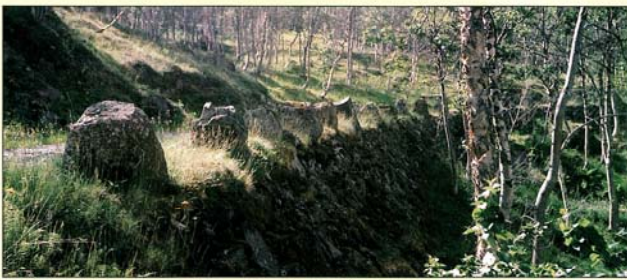
Gamlevegen i Øksfjordbotn. Eksempel på tørrmuring og stabbesteiner. Bygget 1905 - 1910 og restaurert i 1995.
