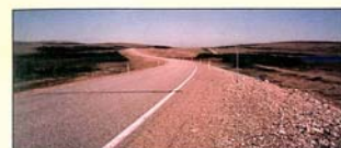
Børsølsfjellet. Eksempel på gammel og ny veg side om side. Legg merke til hvordan vegene er lagt i terrenget. Nyvegen fra 1975 - 1981 er mye høyere og såkalt myk, horisontal trasert. Gammevegen fra 1934 - 1940 er lavere i terrenget og går rett gjennom landskapet, stort sett vertikalt trasert.
