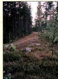
Trallebanen på Jordanfoss i Pasvik. Den er bygget opp i terrenget med stein. Svillene og skinnene er fjernet. Det var flere trallebaner langs Pasvikelva. De første begynte man å bygge på slutten av 1800-tallet. Denne sto ferdig i 1926.
