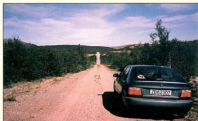
Børsølsfjellet. Et godt eksempel på hvordan vegene fra 1930-tallet gikk snorrett gjennom landskapet, over bakkeopper i stedet for rundt.
