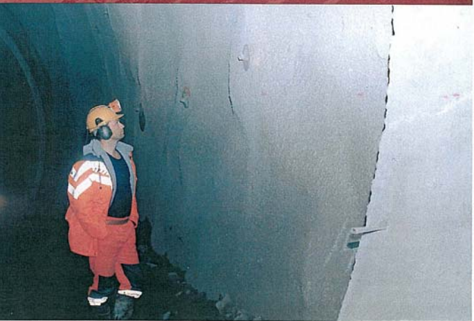
Kontrollingenør Torkild Andal er godt fornøyd med den nye sprøytemetoden. Miljøet under sprøyting er forbedret og samtidig klarer de å opprettholde den hvelv-virkninga som tunnelen skal ha. De siste 25-30 meterne med tunnel på Veidnes er sikret med sprubetong og bolter. Her står han ved overgangen mellom full utstøping og sprubetong. FOTO: BERNT-AKSEL JENSEN
