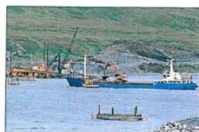
Senkekassene stikker ikke mange meter over havoverflata. Her er entreprenøren Selmer igang med å sette kassene på plass og forankre disse på havbunnen. FOTO: BERNT-AKSEL JENSEN
