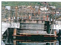
Senkekassene til Kobbhollet bru produseres i Sarnespollen. Her ser vi prinsippet med at betongisloen jekkes ned i sjøen, etterhvert som glideforskalinga klatter oppover. FOTO: BERNT-AKSEL JENSEN
