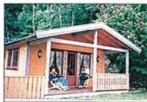
Hytta i Bamble i Telemark var fin og ny, men har ikke innlagt vann og avløp. Men nok av tulleplass utenfor og flott beliggenhet.
