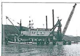
Det må ryddes plass på havbunnen der senkekassene skal plasseres, både med sprengning og mudring. Grunnarbeidene på Kobbhollet bru var vanskelige fordi det var uvanlig mye sand og leire som seg inn og fylte sjøen.
